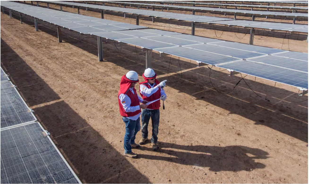
Huatacondo (Chili) — Nos équipes ont achevé en 2018 les travaux de la centrale photovoltaïque, d'une puissance de 103 MWc.
