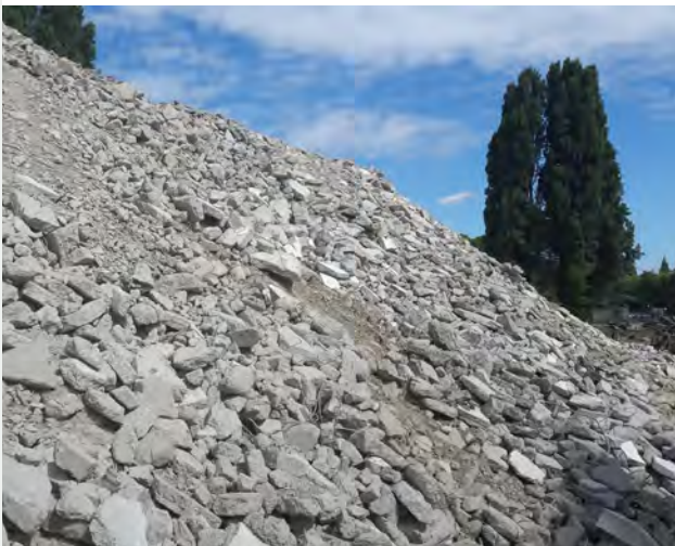
La déconstruction sélective nous permet de séparer et de trier sur place les différents éléments démolis afin de favoriser leur recyclage ou leur réemploi.
