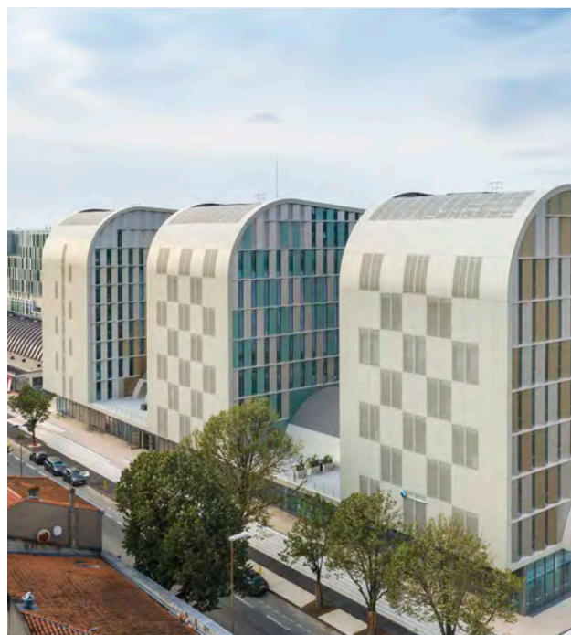
Bordeaux (France) — Eiffage Immobilier a livré la Halle Boca au cœur du quartier Euratlantique, opération mixte de 23 500 m 2 .
