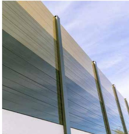
Modern, formvollendet und einseitig hochabsorbierend: unsere Lärmschutzwand aus Aluminiumwandelementen für den DB Rangierbahnhof Maschen. In einer nur 51-tägigen Sperrpause wurden ca. 4.200 m<sup>2</sup> Aluminiumwandelemente errichtet.
