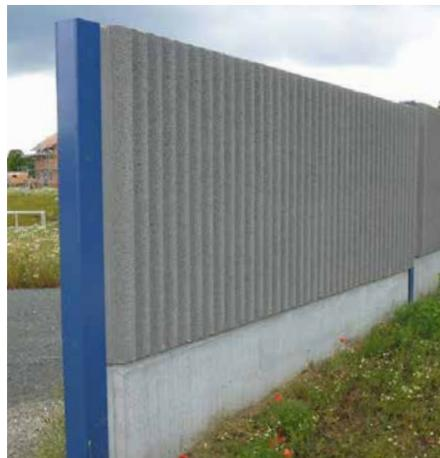
Robust, witterungsbeständig, sicher, langlebig, wartungsarm – das sind nur einige der vielen positiven Attribute von Lärmschutzwänden aus Stahlbeton. Am viel befahrenen Schenkendamm in Braunschweig realisierten wir eine Lärmschutzwand aus gewichtigem Stahlbeton auf einer Gesamtlänge von 310 Metern.
